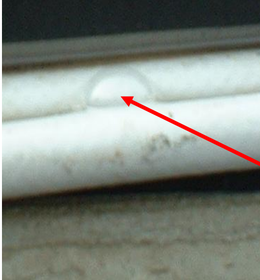
Bild 7. Diese Meßmethode (Nachweis mit schaubildendem Mittel) weist zwar eine Undichtigkeit nach, gibt jedoch keinen Hinweis auf Gasqualität noch Gasquantität
